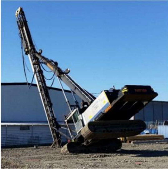
Figur 2-2. Tippningen inträffade enligt uppgift under en snabb rotation med för långt utligg med hejare och påle. Troligen var rotationen tillräckligt snabb för att ge upphov till så stora tröghetskrafter i utligget att tippningen uppkom. Arbetsplattformen bedöms ha varit tillräcklig.
