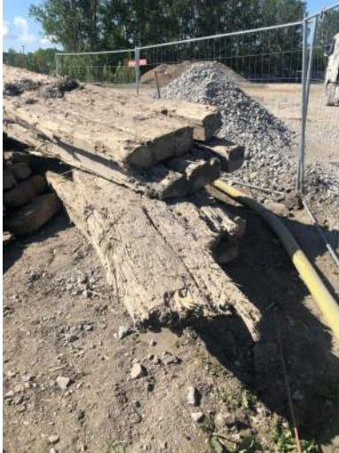
Figur 8-1. Stockmattor i dåligt skick
