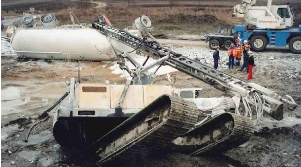
Figur 2-4. Schakt och återfyllning hade utförts efter arbetstidens slut i det område där KC-pelarmaskinen arbetade. Återställning och packning av området hade inte genomförts på ett korrekt sätt. Man hade inte hunnit med att göra det.
