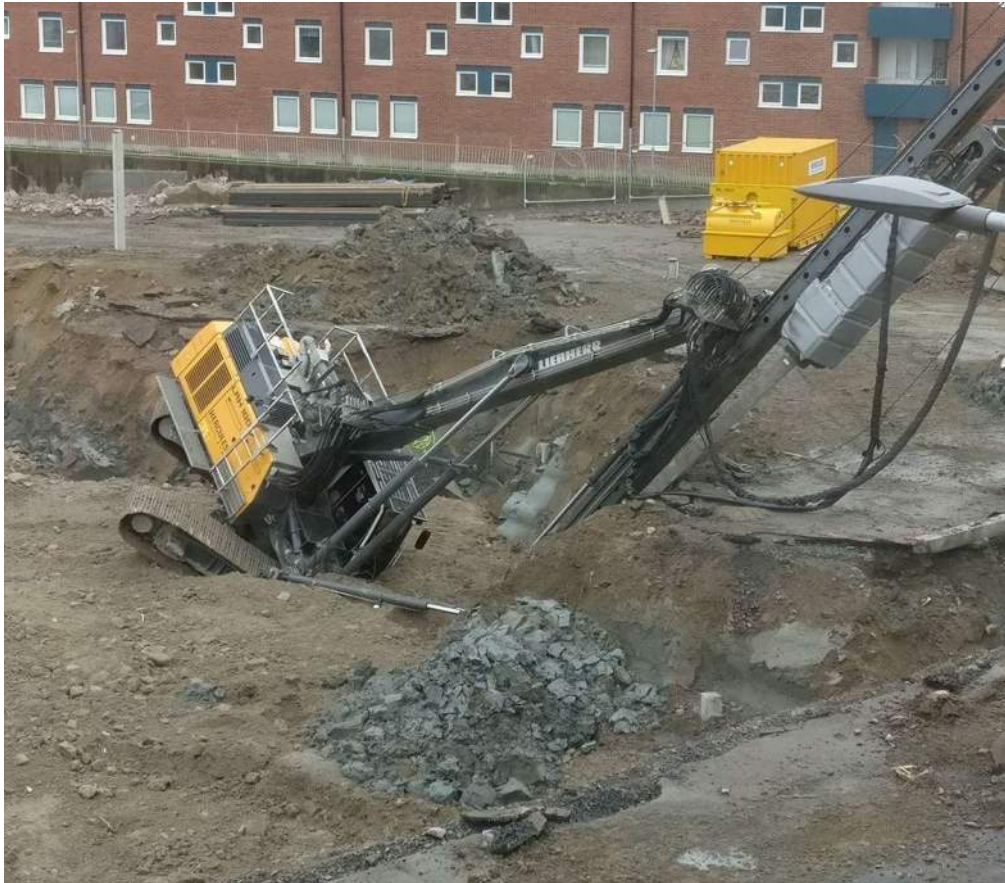
Figur 2-6. Den naturligt lagrade jorden utgjordes av lera med mycket låg odränerad skjuvhållfasthet och hög sensitivitet högt i profilen. Leran var eventuellt överlagrad av torrskorpelera. En arbetsplattform var projekterad att utgöras av stockmattor lagda vinkelrätt larver på ett 0,9 m mäktigt krosslager. Mastens position, låg snett utanför framkant av den ena larven vilket gav en hög tyngdpunkt av påle och hejare.
