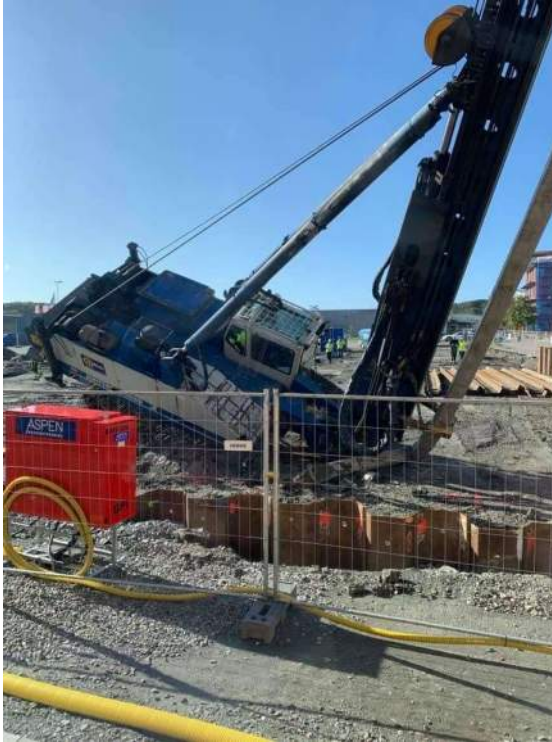
Figur 2-5. Bärighetsbrott under larv, eventuellt på grund av att man tidigare utfört en provgrop i detta läge som inte återfyllts och packats korrekt. Hög tyngdpunkt av påle och hejare.
