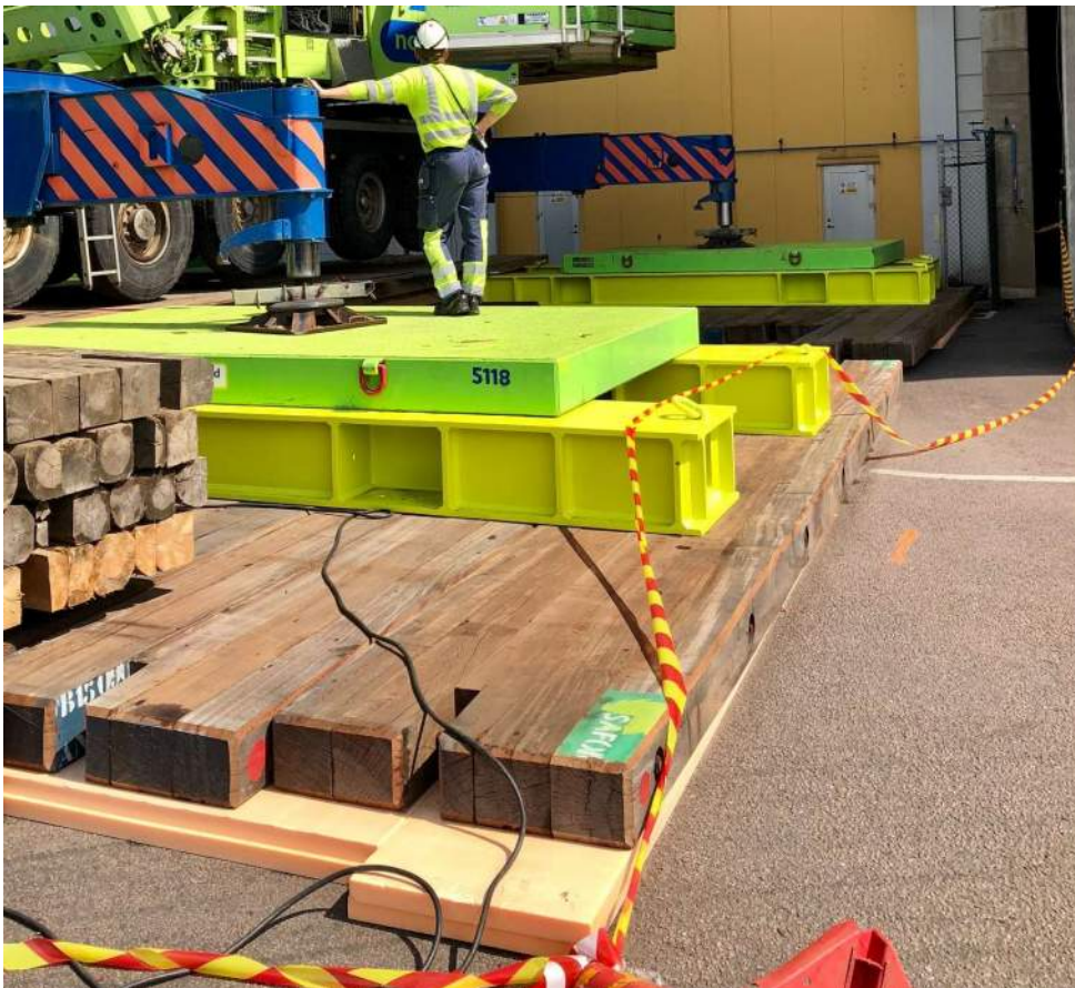
Figur 8-2. Uppställning av en mobilkran med hjälp av lastsfördelande konstruktionselement
