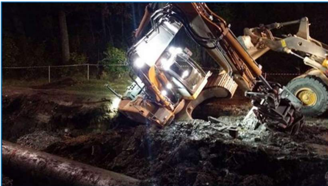
Figur 2-3. Ett stabilitetsbrott i extremt lös lera inträffade i naturligt lagrad jord intill en långsträckt schakt. Det upptäcktes att underlaget var sämre än förväntat men arbetet fortsatte.
