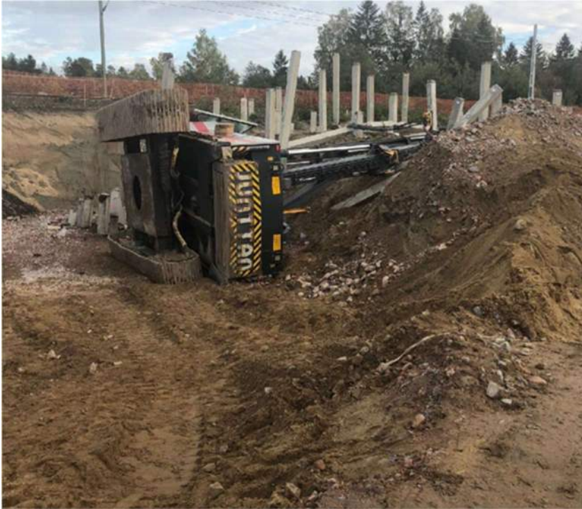
Figur 2-9. Orsak till vältningen är inte känd. Arbetsplattformen kan ha varit otillräcklig och/eller en indragning av en påle kan ha lett till stora horisontella krafter och ett för stort tippande moment.
