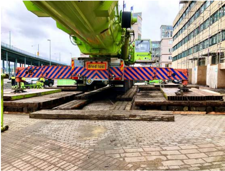
Figur 7-2. Provbekastning utfördes i samband med denna uppställning av en mobilkran
