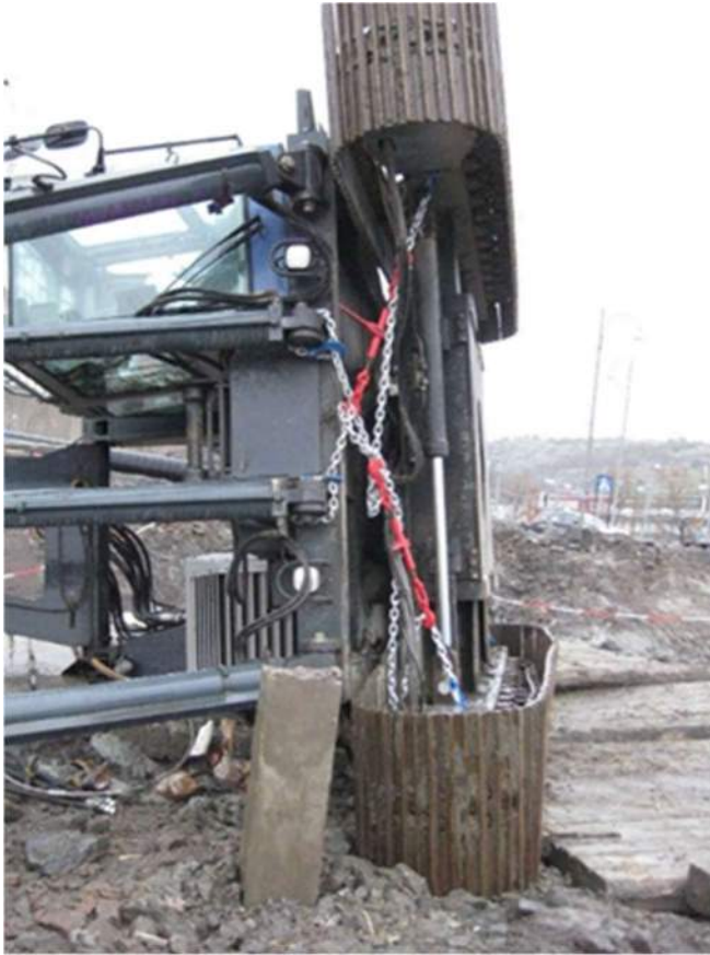
Figur 2-1. Jorden utgjordes av lera och arbetsplattformen av en fyllning på ca 0,40 - 0,5 m med stockmattor. Maskinen stod för nära kanten av stockmattorna. I anslutning till arbetsplattformen hade man tagit ett antal lerproppar med augerborr innan pålningen utfördes.
