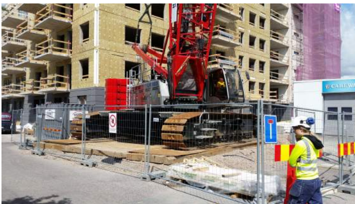
Figur 7-3. Provbekastning utfördes i samband med denna uppställning av en larvgående kran
